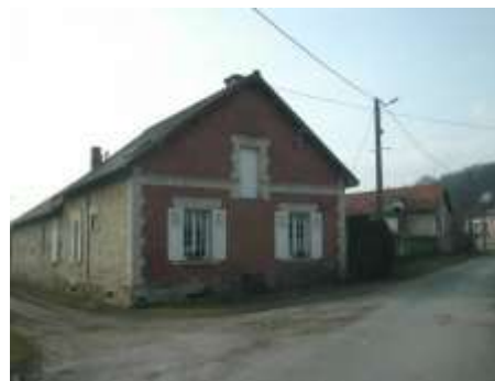
Bâti de la Reconstruction - Aizy-Jouy
