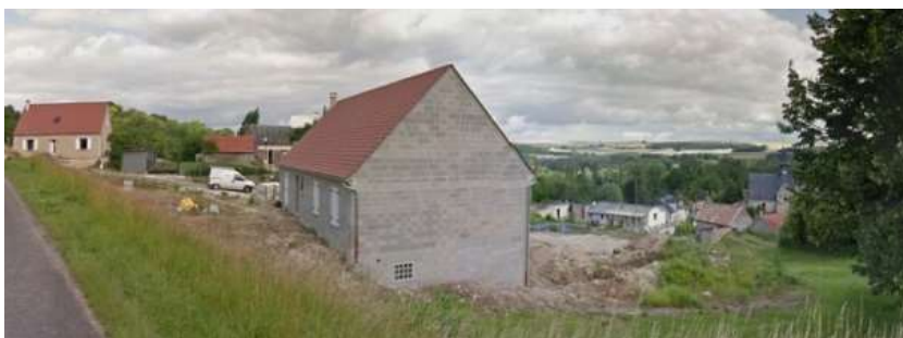
Exemple d'une nouvelle construction implantée en ligne de crête
